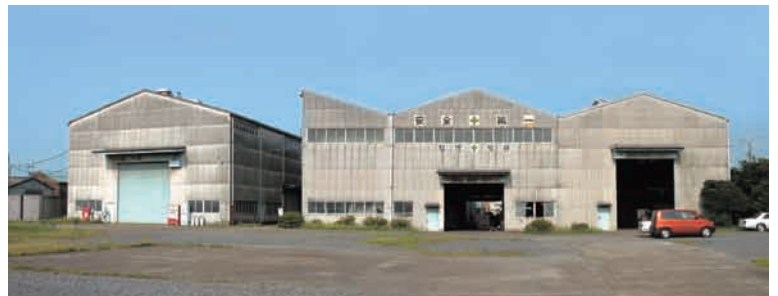
石油鑿井機製作古河工場
